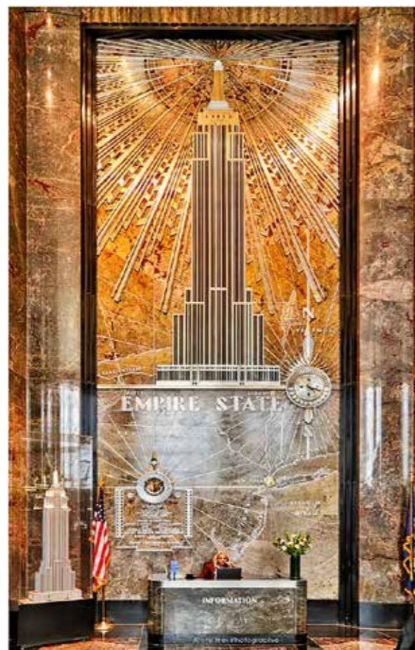
Im Foyer des Empire State Buildings wurden große Mengen Lahn-Marmor verschiedener Varietäten verbaut.
